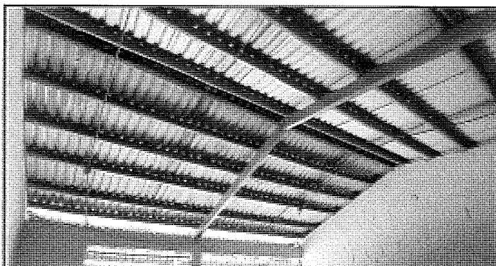
PINTADO CON PINTURA ANTICORROSIVA DE SECADO RÁPIDO A LA ESTRUCTURA METÁLICA DEL TECHO, TRABAJO TERMINADO.
