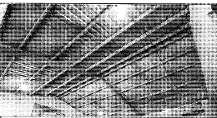
ESTRUCTURA METÁLICA TERMINADA, PINTADA CON TRES MANOS DE PINTURA ANTICORROSIVA.
