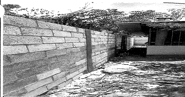
CONSTRUCCIÓN DE MURO PERIMETRAL.
